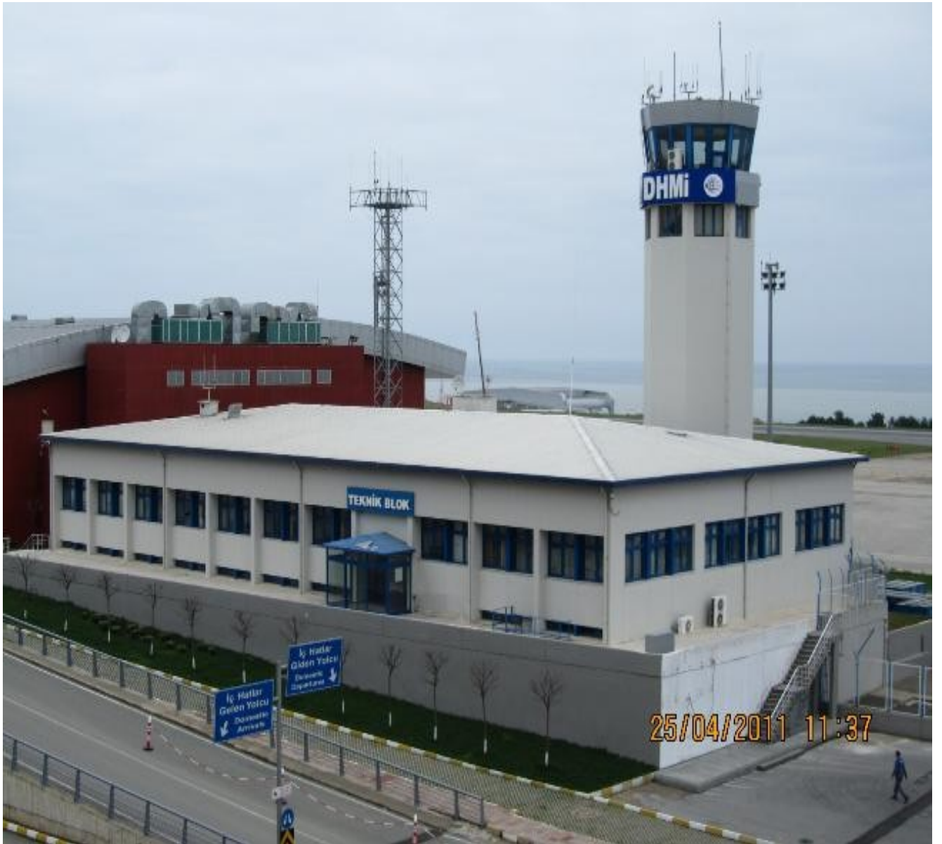
Şek.2.1 Trabzon hava limanının dispetçer idarəsi
