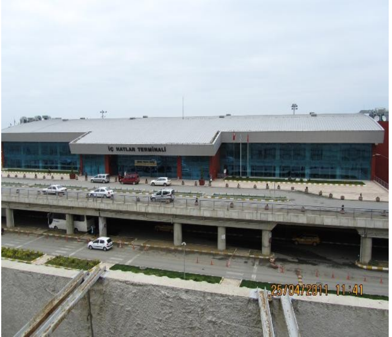
Şek.3.1 Trabzon hava limanının daxili terminalinin ümumi görünüşü
